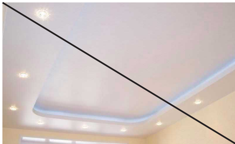
Плохо Многоуровневые гипсокартонные конструкции
